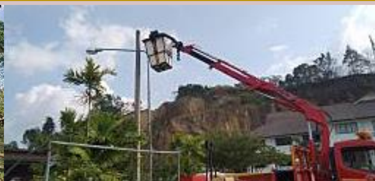
งานบริการ สาธารณูปโภคของ กองช่าง อาทิ ตัดกิ่งไม้ ซ่อมไฟฟ้า สาธารณูปโภค ฯลฯ
